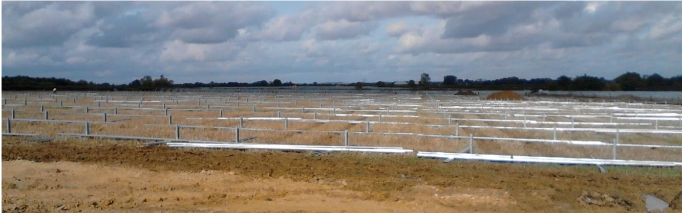
Inicio de ejecución de los trabajos en la planta
